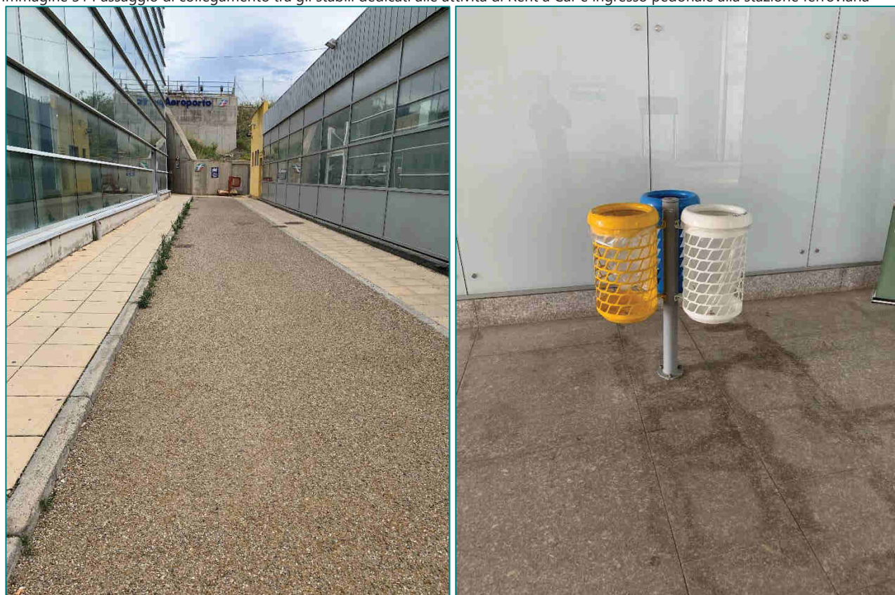
Immagine 31 Passaggio di collegamento tra gli stabili dedicati alle attività di Rent a Car e ingresso pedonale alla stazione ferroviaria
