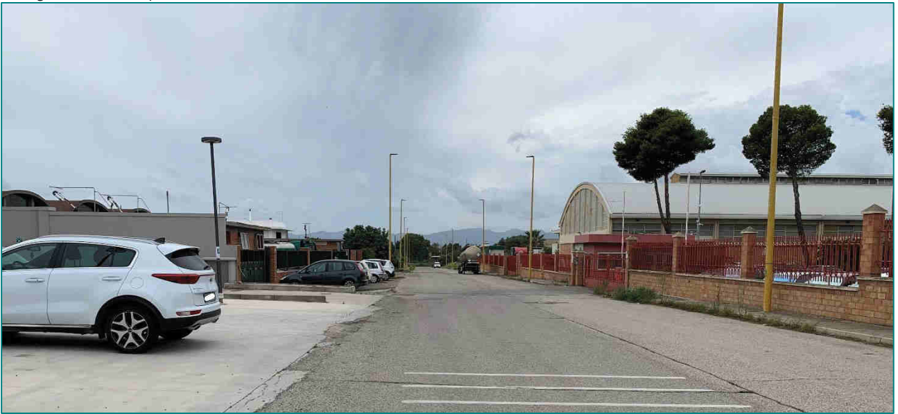
Immagine 11 Edificato prevalente nella Zona Industriale del Comune di Elmas – via delle Miniere
