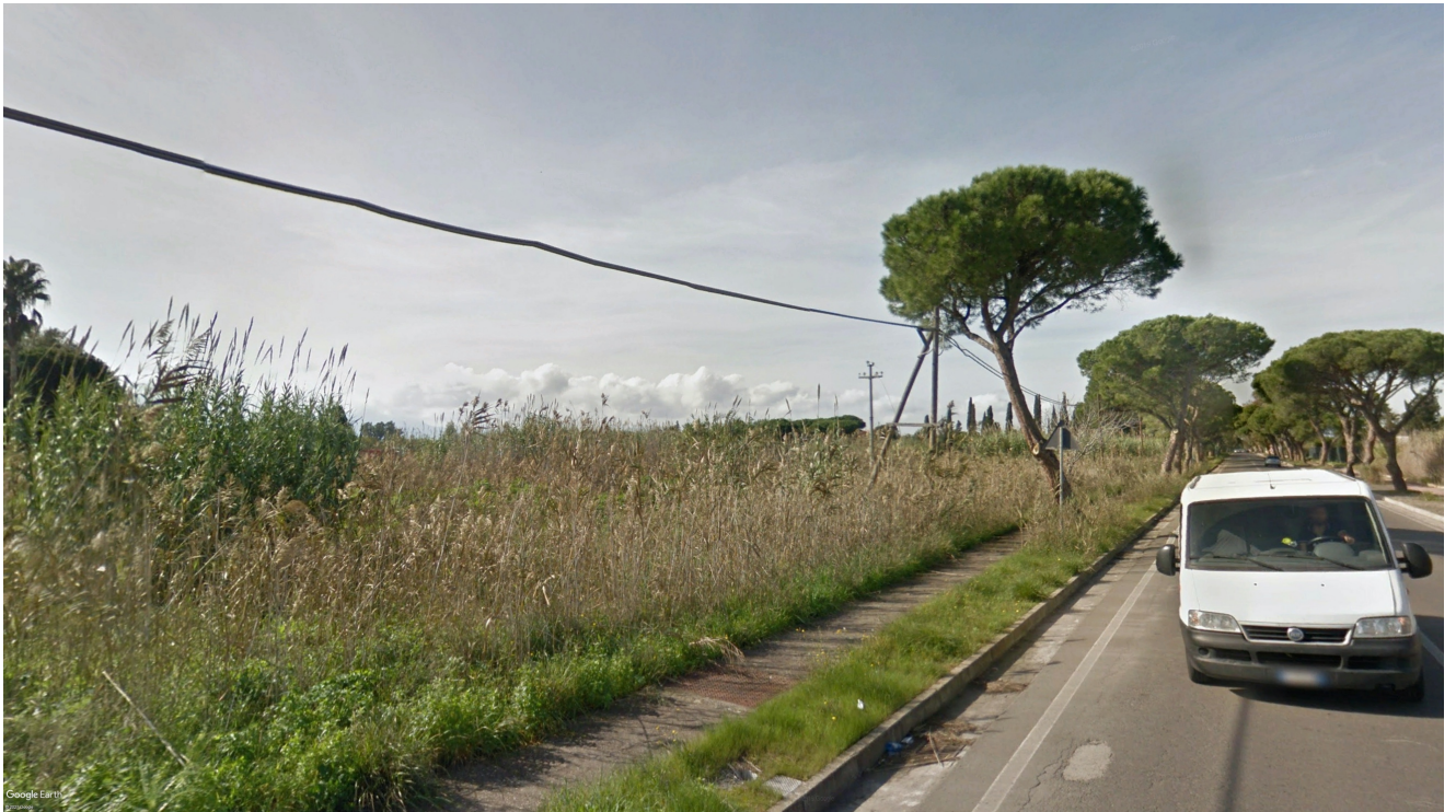
Figura 15 - Vista della Via Sulcitana - Stato attuale
