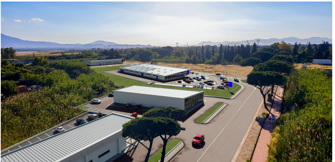
Figura 16 - Ulteriore vista dall'alto del lotto di intervento
