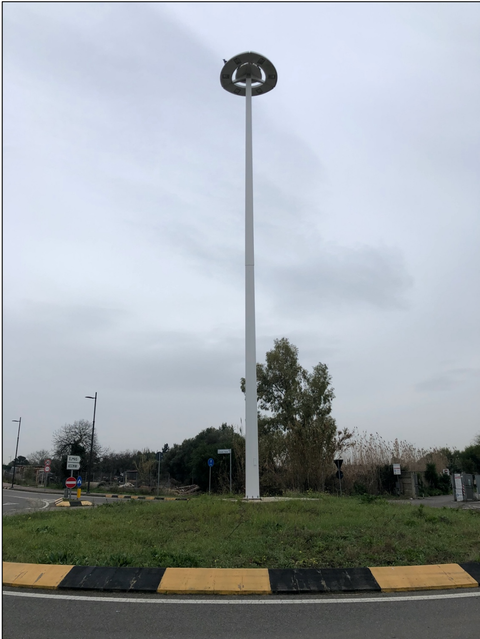
Figura 8 - Torre faro esistente, nella rotonda esistente tra la via Carloforte e la via Antonio Tocco
