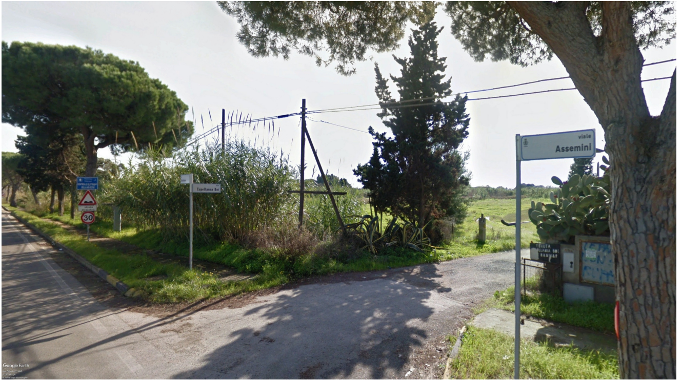
Figura 8 - Vista della via Sulcitana – Stato attuale
