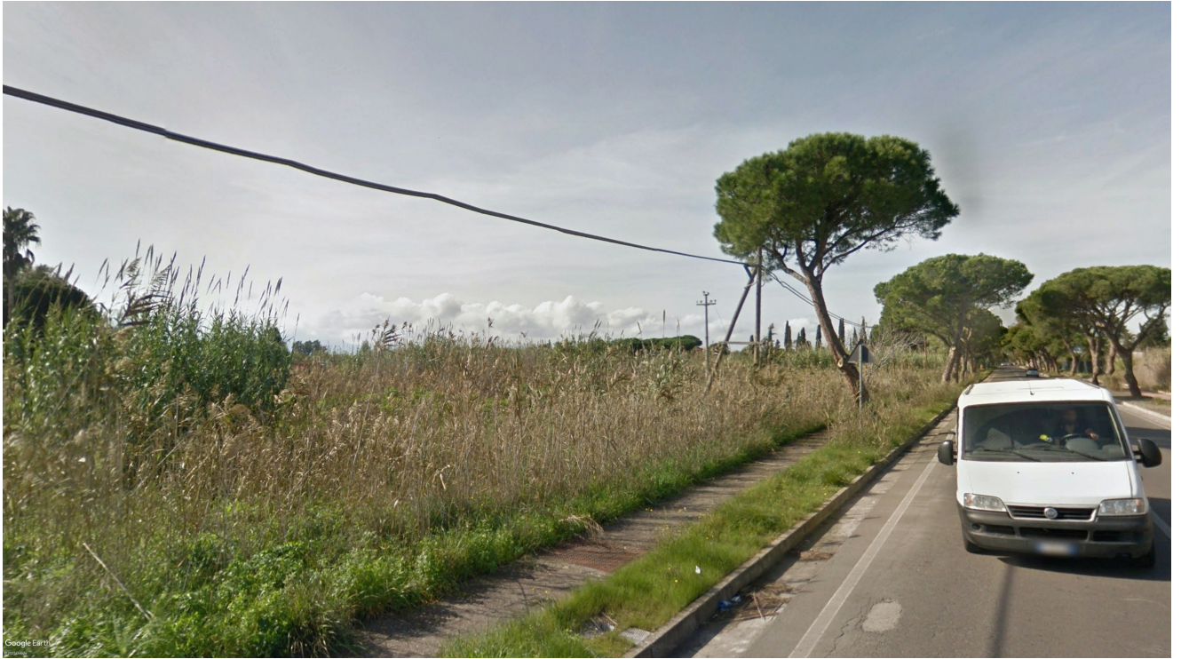
Figura 12 - Vista della Via Sulcitana - Stato attuale
