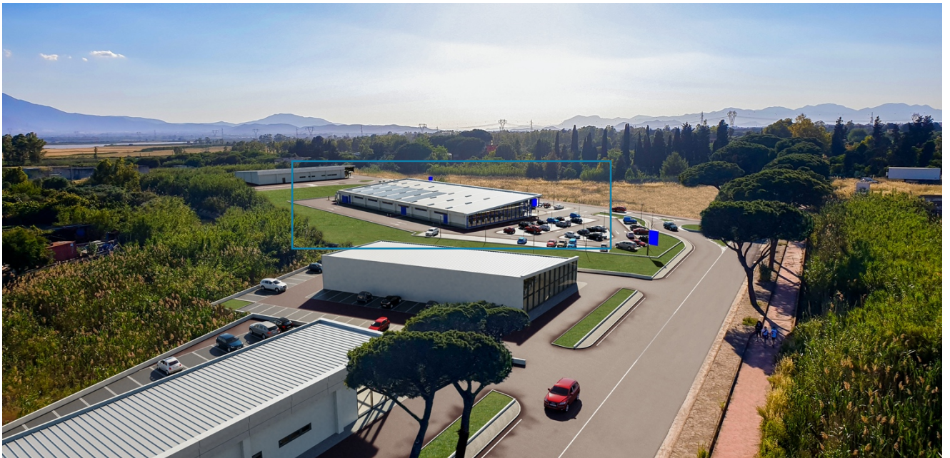
Figura 13 - Ulteriore vista dall'alto del lotto di intervento
