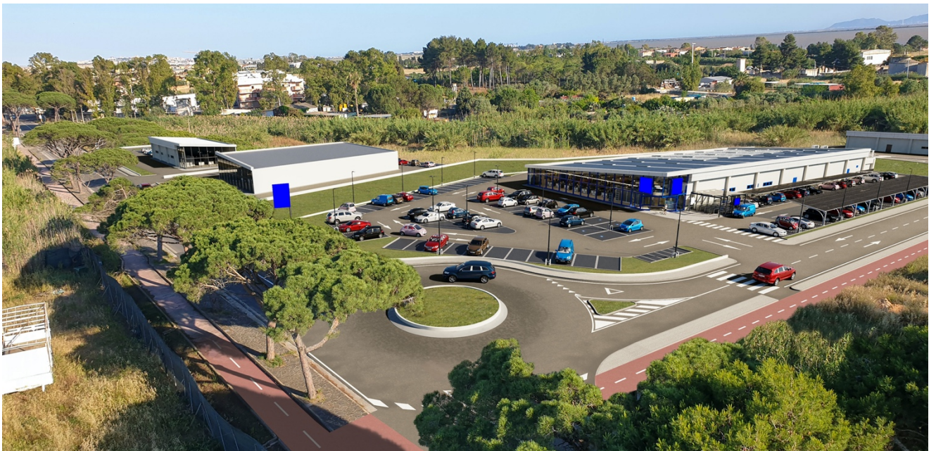
Figura 12 - Vista dall'alto del comparto di intervento
